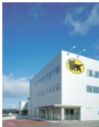
ヤマト運輸はネットワーク全体ではなく、主管支店単位で減損処理を実施している（写真は2月に稼働した三重主管支店）
